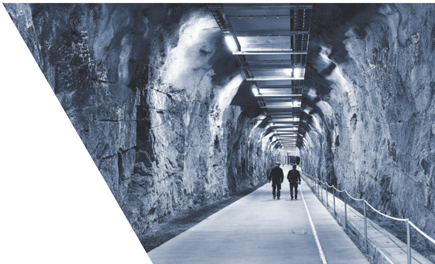
Vandkraftværk i Sisimiut
